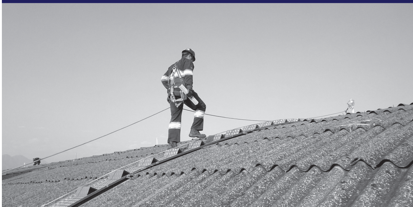
Linha de vida em telhado e passarela com degraus
